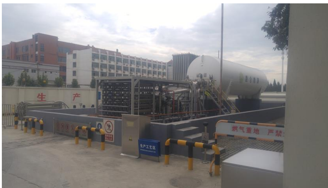
Рисунок 2.5 Емкость для хранения СПГ на КриоАЗС
